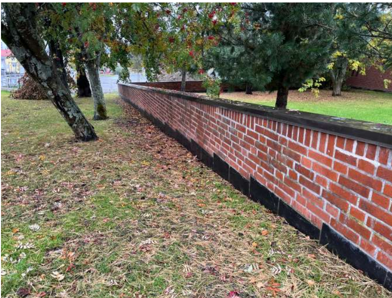
Muren mot Lasarettsvägen med trappad skiffersockel. Foto: författaren
