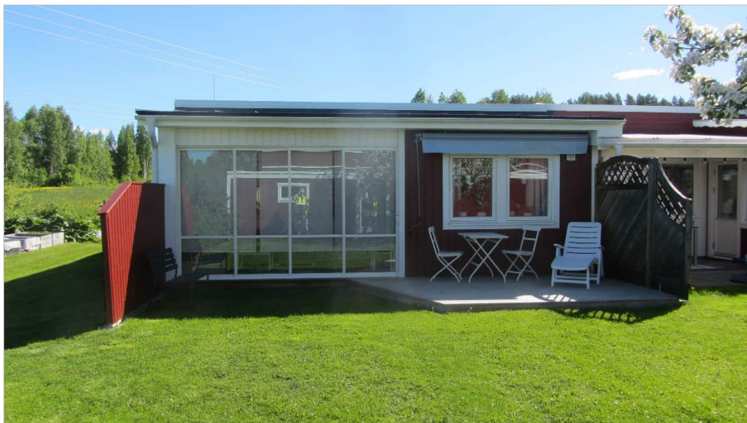
Figur 3.6: Exempel på en befintlig fastighetsnära bullerskyddsskärm.
