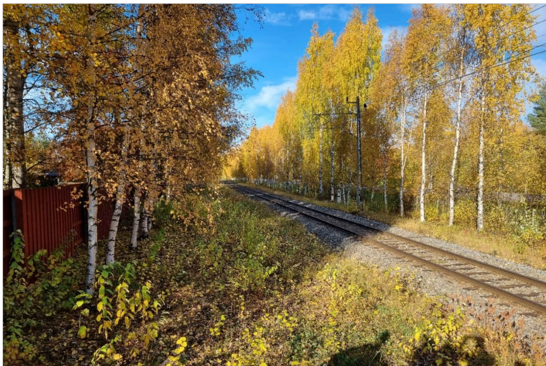
Figur 3.2: Befintlig bullerskyddsskärm vid spår (Fågelgatan).
