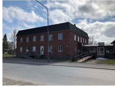
Fasad mot gatan 2021.
