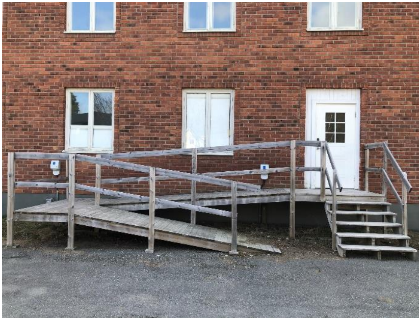
Gatufasaden har förvanskats med dörr och ramp.
