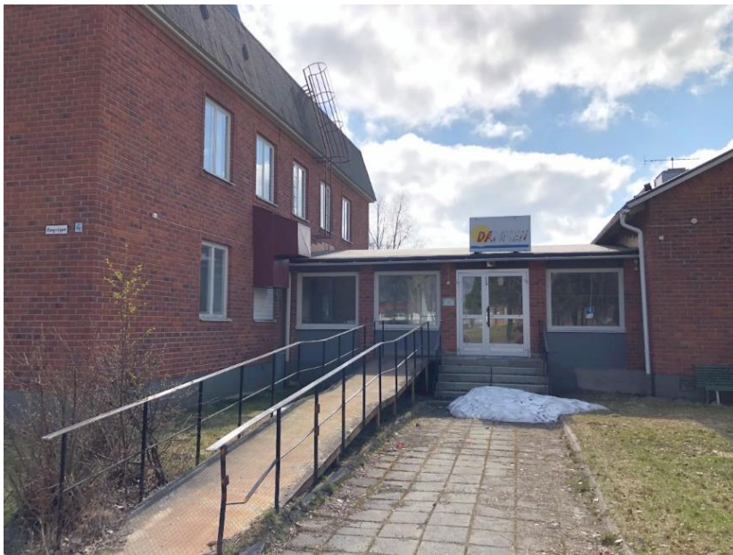
Kommunalhusets huvudentré har tyvärr förvanskats med en ny port.
