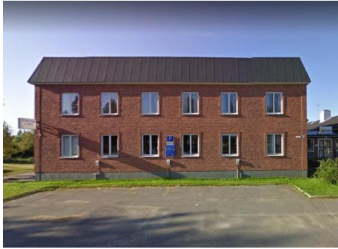
Fasad mot gatan 2009.
