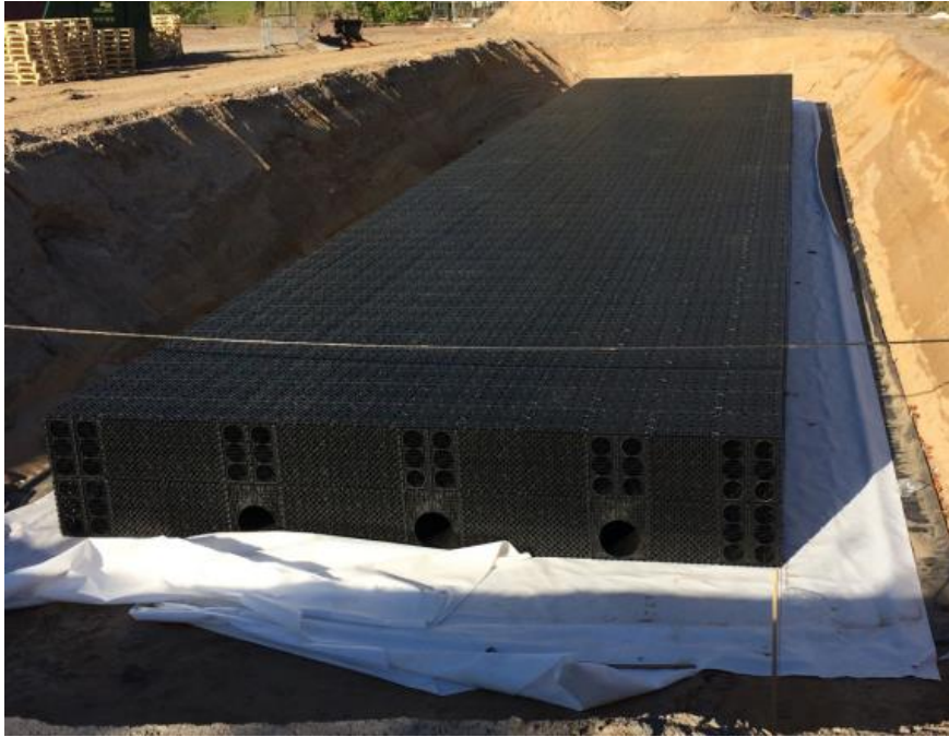
Figur 20. Dagvattenkassetter i urschaktad grop. Foto: Stockholm Vatten och Avfall.
