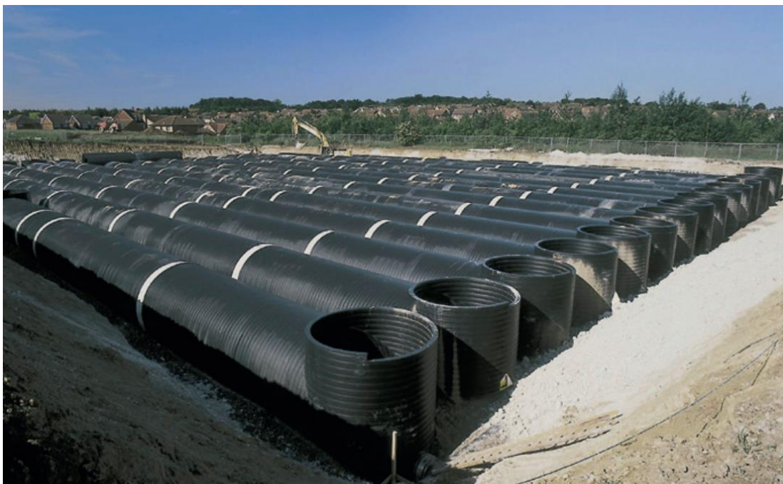
Figur 21. Rörmagasin i urschaktad grop. Foto: Stockholm Vatten och Avfall.
