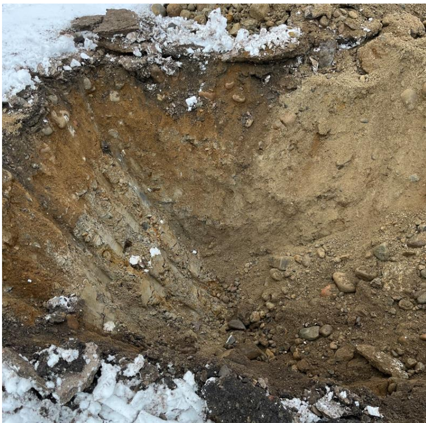
Figur 8. Provgrop 22W02PG. Sandig grusig fyllning överlagras siltig lera
