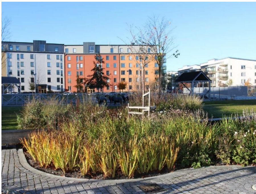
Figur 13. Exempel på nedsänkt växtbädd (Solna stad dagvattenstrategi, 2018).
