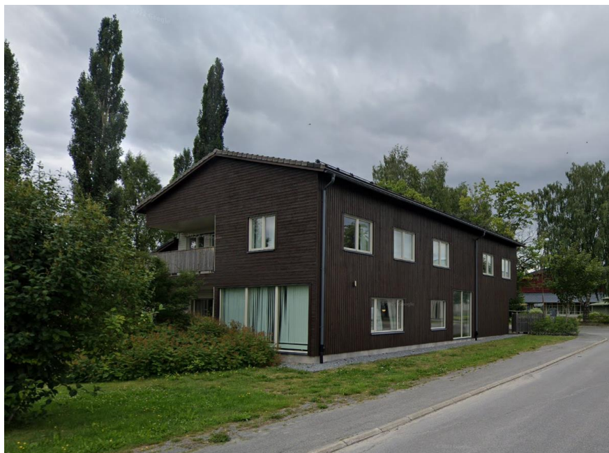
Bild 6. Befintlig byggnad inom planområdet som tillhör studentföreningen
