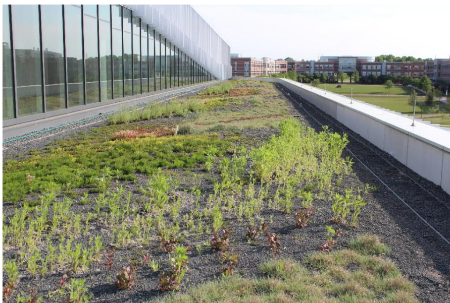
Figur 15. Exempel på grönt tak (Foto av Søberg, 2014).
