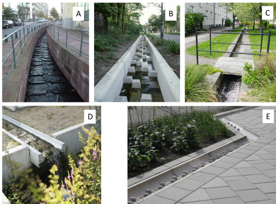
Figur 14. Olika exempel på öppna kanaler för dagvatten. A: kanal i stadsmiljö med "trappstegsbotten" (Bild av Lars-Erik Widarsson, NSVA); B: kubbäck med hoppstenar (Bild från S:T Eriks); C: simpel kanal med övergång (Bild av Johanna Sörensen, föreningen Sveriges Stadsbyggare); D och E: mindre kanal i form av lökränna (Bild från S:T Eriks).
