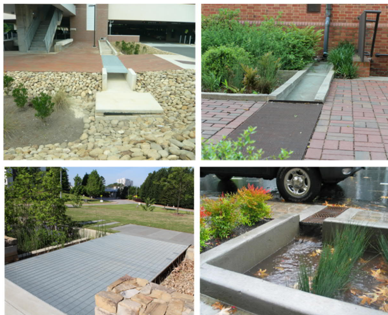
Figur 7. Olika typ av galler som fungerar som bro (gångyta) över kanal för att bibehålla funktionen av gång- och/eller cykelväg (Bilder av Laila Søberg, 2014).
