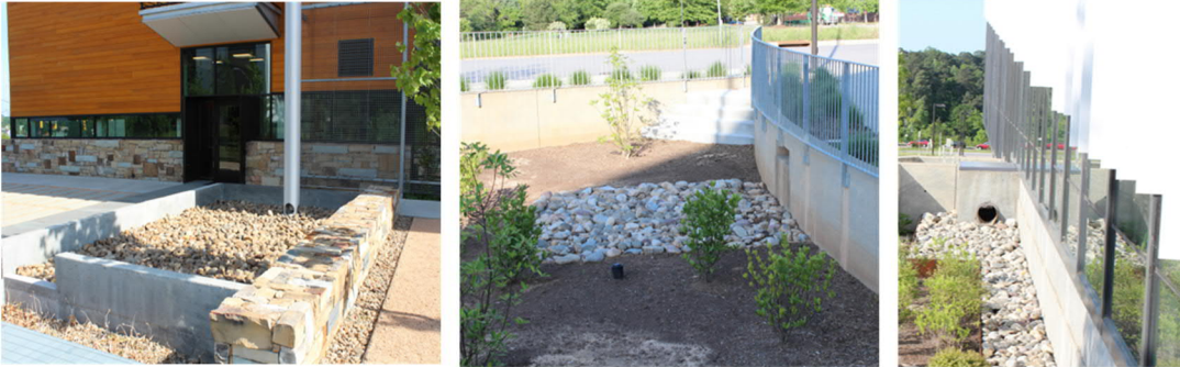
Figur 12. Exempel på förbehandling. Förbehandling syftar till att bromsa flödet så erosion av anläggningsytan undviks (Bilder av Laila Søberg, 2014).
