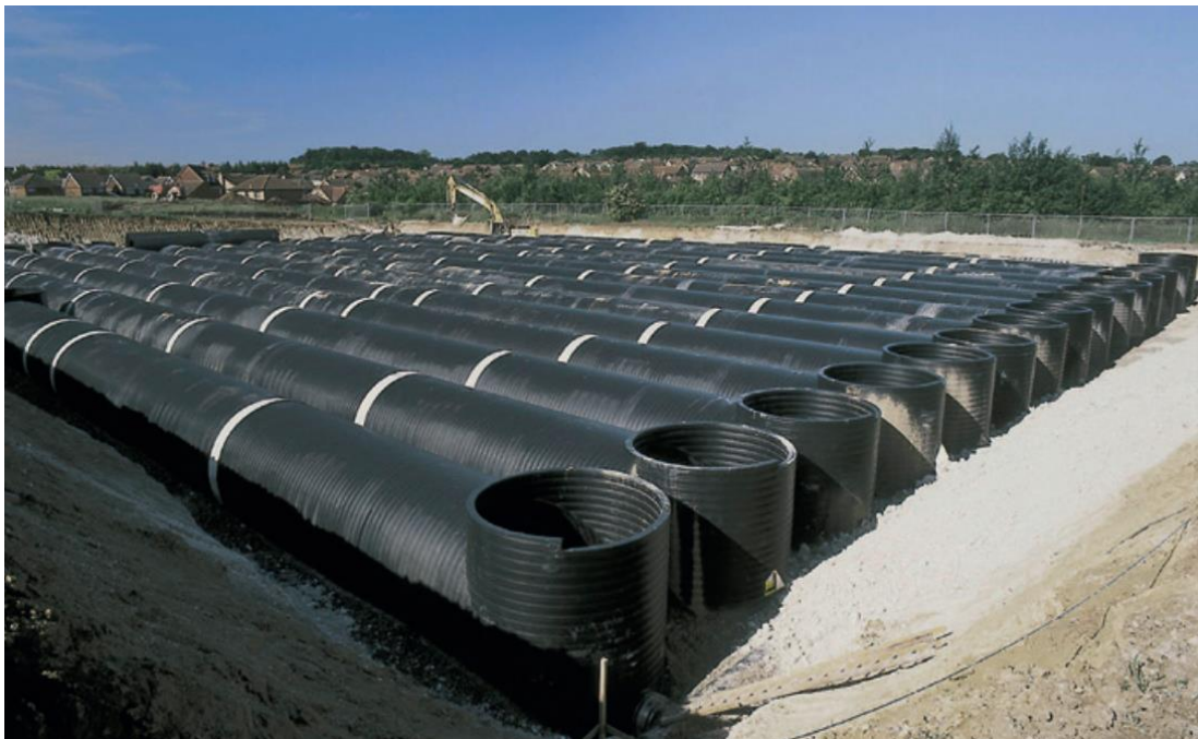
Figur 20. Rörmagasin i urschaktad grop. Foto: Stockholm Vatten och Avfall.
