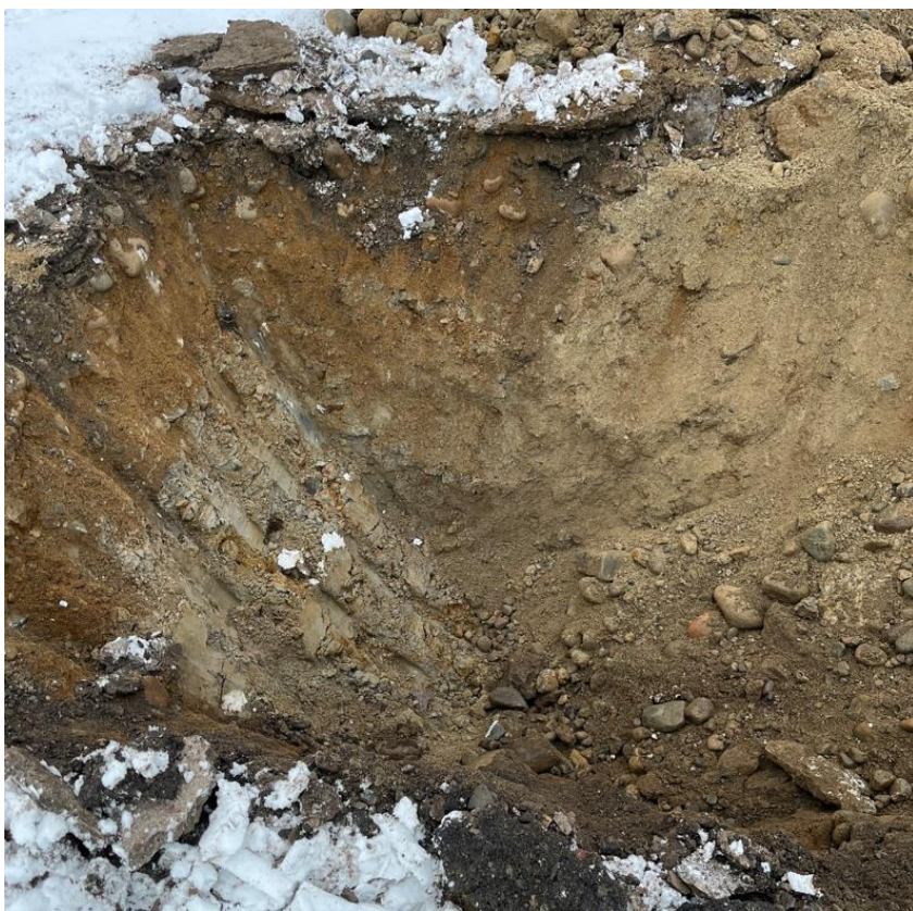
Figur 7. Provgrop 22W02PG. Sandig grusig fyllning överlagras siltig lera
