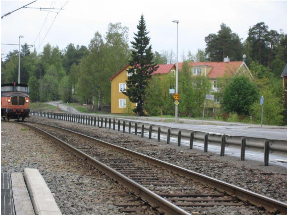
Bild 9. Järnväg, väg och bostäder på Kallholmen
