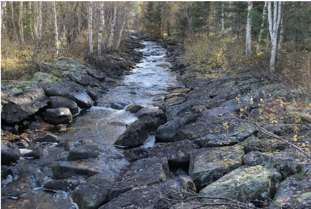
Figur 2: Kanaliserad sträcka med släntmur på båda sidor.
