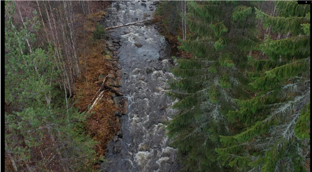
Figur 7: Område 1 i Svartån efter åtgärd där släntmur på vänstra sidan har lämnats orörd.
