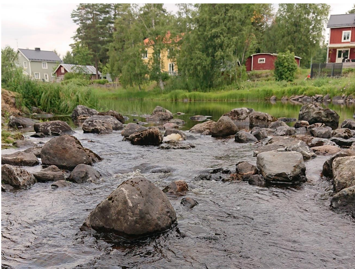
Figur 10: Inloppet till sidofåran efter återställning då en nivåsettande tröskel anlagts.
