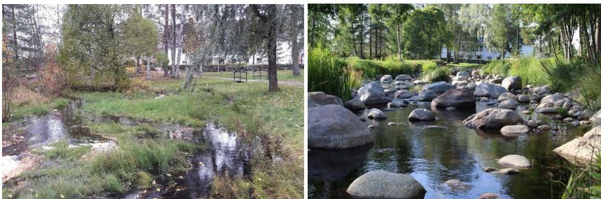
Figur 16: Till vänster foto på sidofåran uppströms övre betongdammen före åtgärd. Till höger samma vy efter åtgärd då dammen tagits bort och ny bäckfåra är uppbyggd. Det råder lågvatten vid tillfället för fotot.
