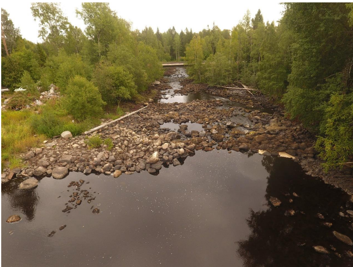
Figur 12: E4-forsen utgjorde ett hinder vid lågvatten. Foto innan åtgärd vid extremt lågvatten
