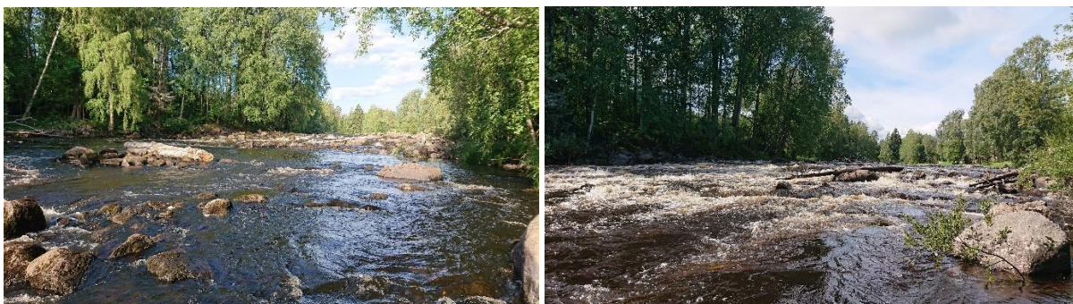
Figur 13: Till vänster före åtgärd syns tröskeln på forsacken som vid lågflöden utgör vandringshinder. Till höger efter åtgärd då forsacken har flyttats uppströms för att skapa en flackare karaktär.
