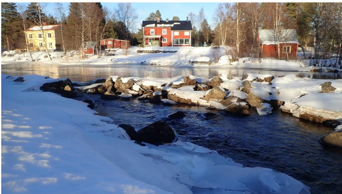
Figur 9: Stenksista som delvis stänger av sidofåran i Yttersforsen Bureälven.
