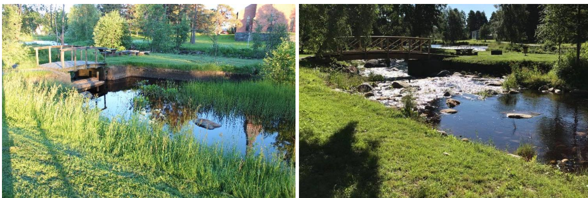
Figur 17: Vy ner mot övre dammen före åtgärd till vänster och efter åtgärd till höger.
