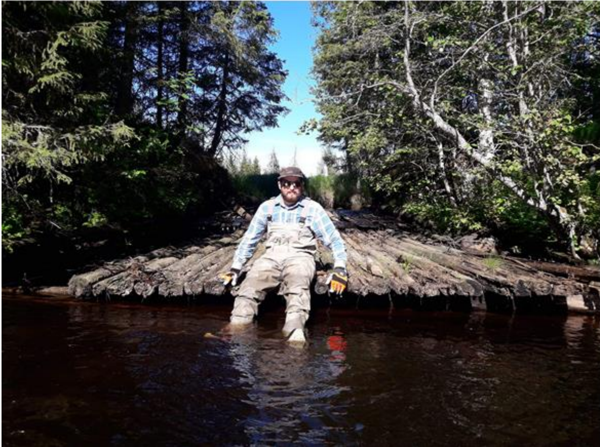
Figur 18 Ett vandringshinder i form av ett gammalt skibord i Bjurbäcken innan restaurering.
