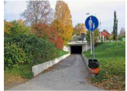
Gångtunnel under järnvägen
