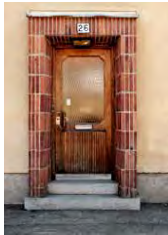
Dörr av ädelträ med tegelomfattning, 1950-tal.
