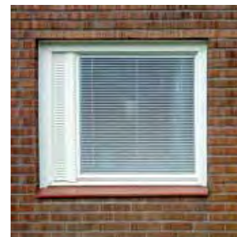
Fönster med vädringslucka, 1960-tal.
