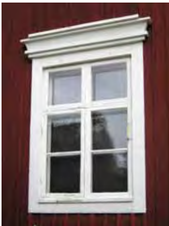
Korspostfönster med profilerat överstycke, 1800-tal.
