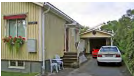
Tillbyggd carport, indragen på gården.
