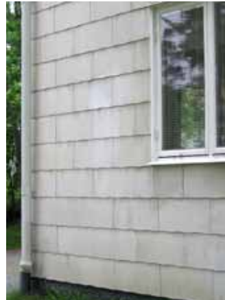
Eternitklädd fasad, 1950-tal.
