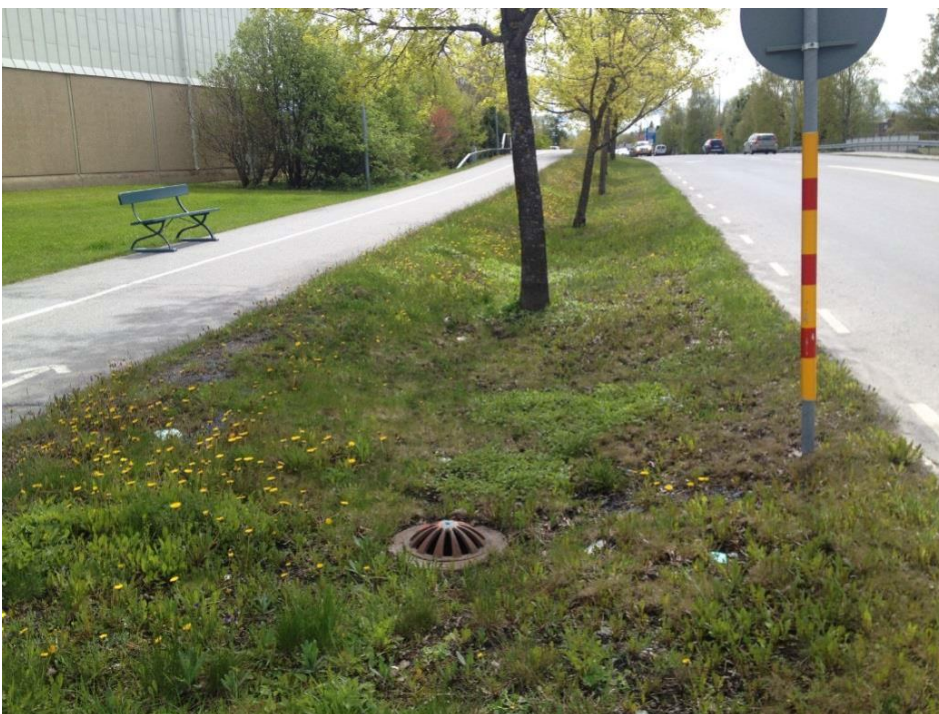
Figur 13. Exempel på svackdike i Östersund. Svackdiket avslutas i en kupolbrunn, men en helt öppen avledning är också möjlig. Foto: Rickard Olofsson, Sweco.
