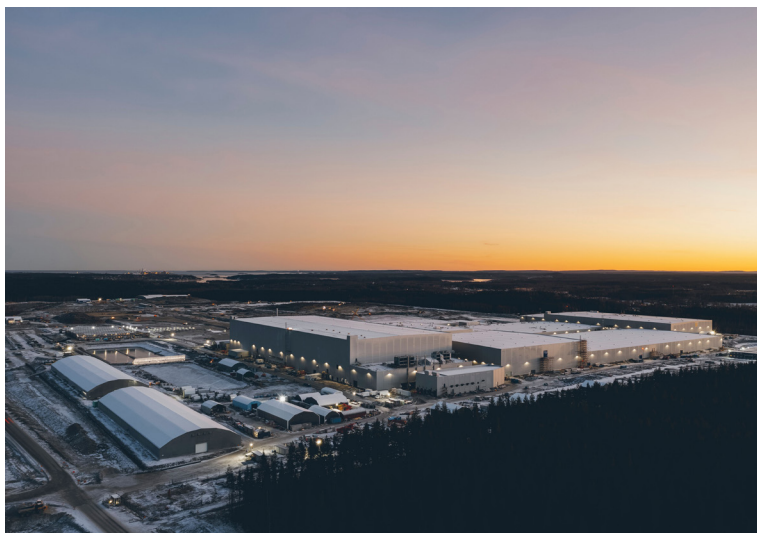
Northvolt batterifabrik, Skellefteå. Foto: Jonas Westling
