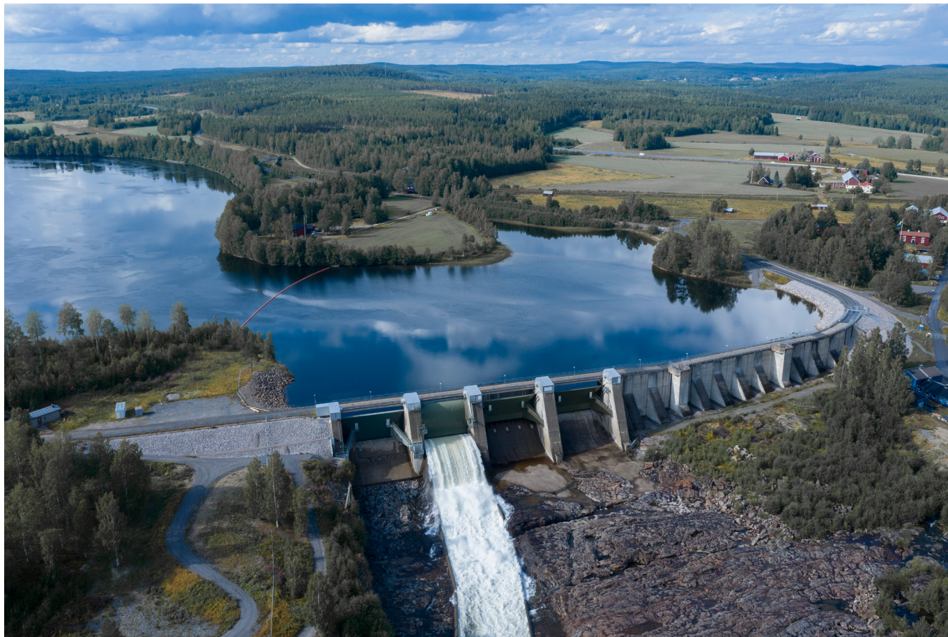
Stornorrfors kraftverksdam. Foto: Jennie Petterson
