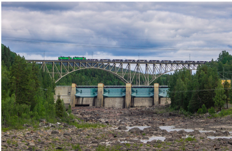
Forsmobron och Forsmo vattenkraftverk. Foto: David Larsson
