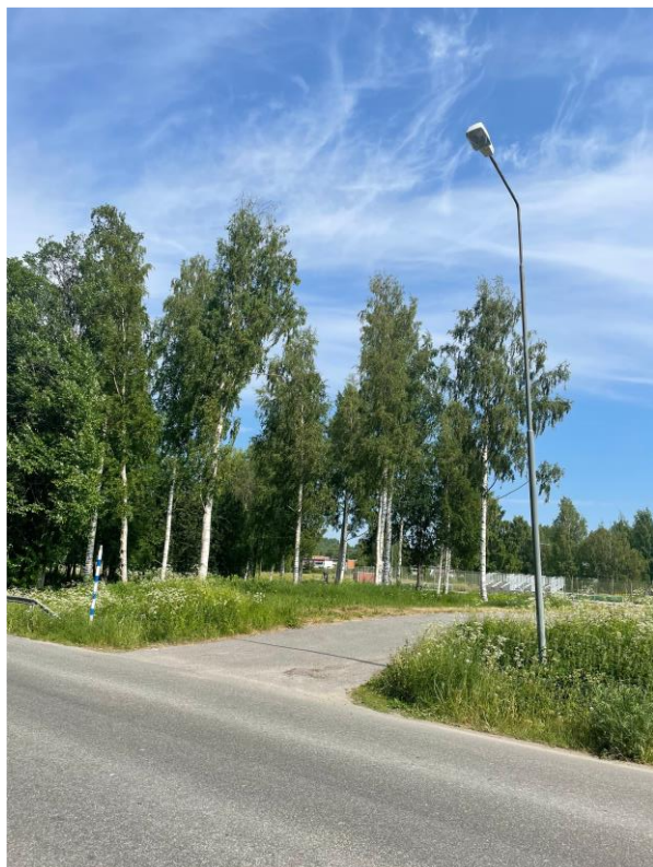
Figur 14: Nordvästra in- och utfarten, juni 2023.
