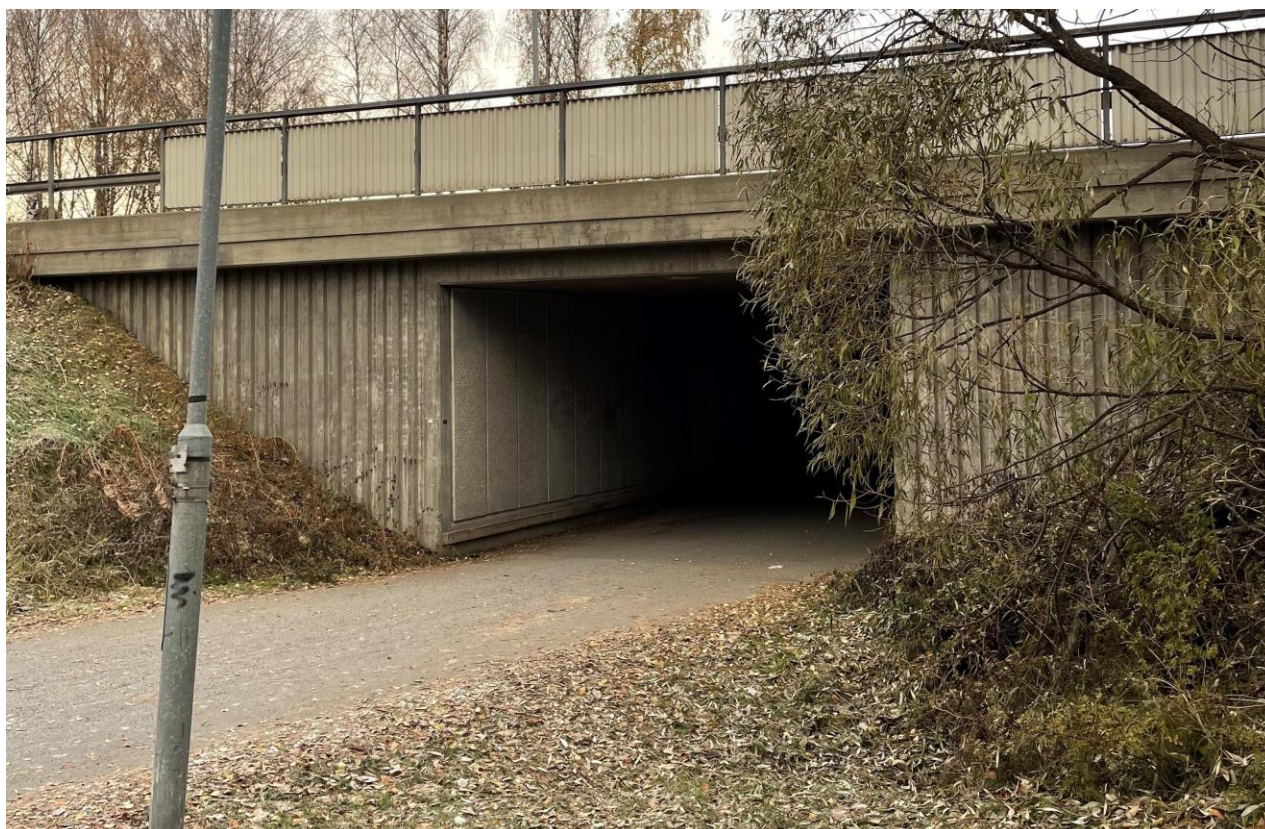
Figur 14: Tunnel sydöst om planområdet, oktober 2023.
