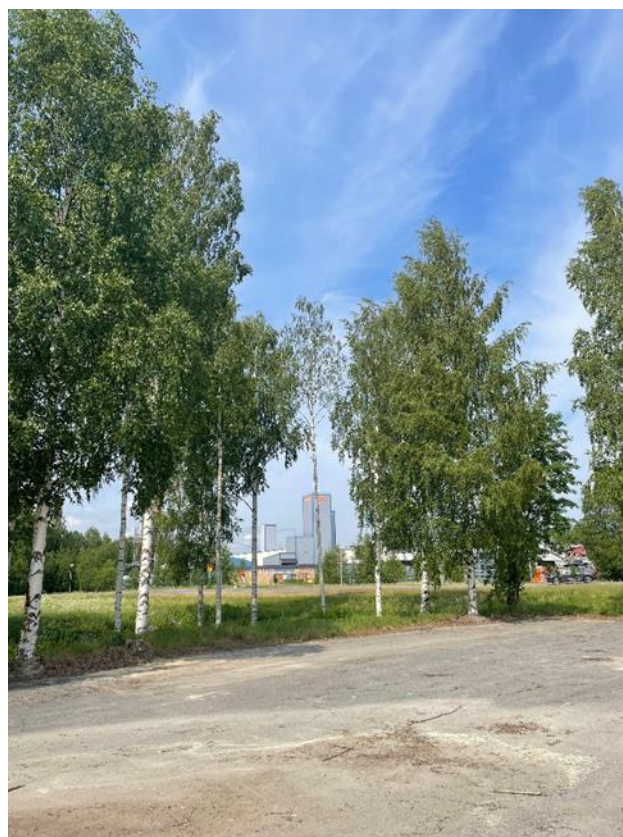
Figur 8: Asfalterad multiyta och sänka, juni 2023.
