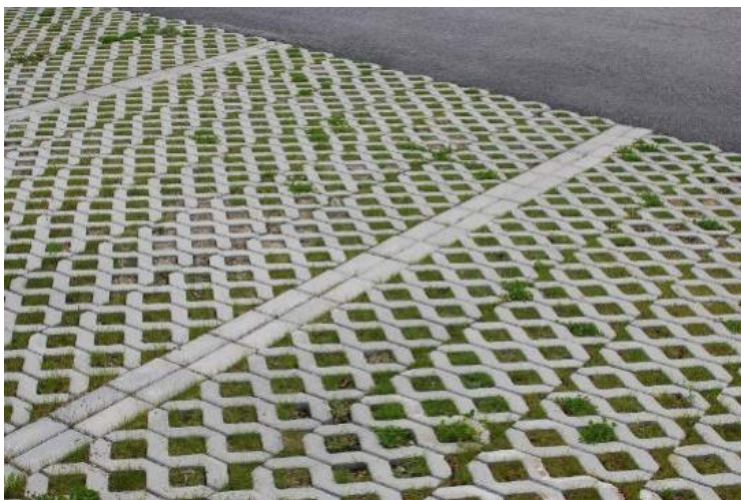
Figur 11. Exempel på vattengenomsläpplig beläggning på parkering. Foto: Sweco.
