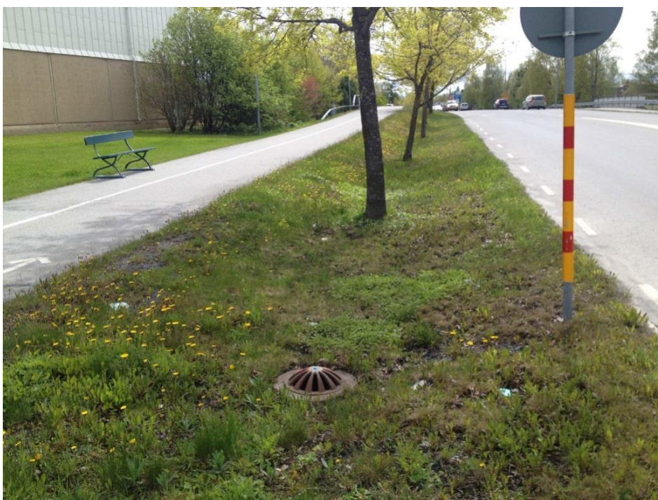
Figur 14. Exempel på svackdike i Östersund. Svackdiket avslutas i en kupolbrunn, men en helt öppen avledning är också möjlig. Foto: Rickard Olofsson, Sweco.
